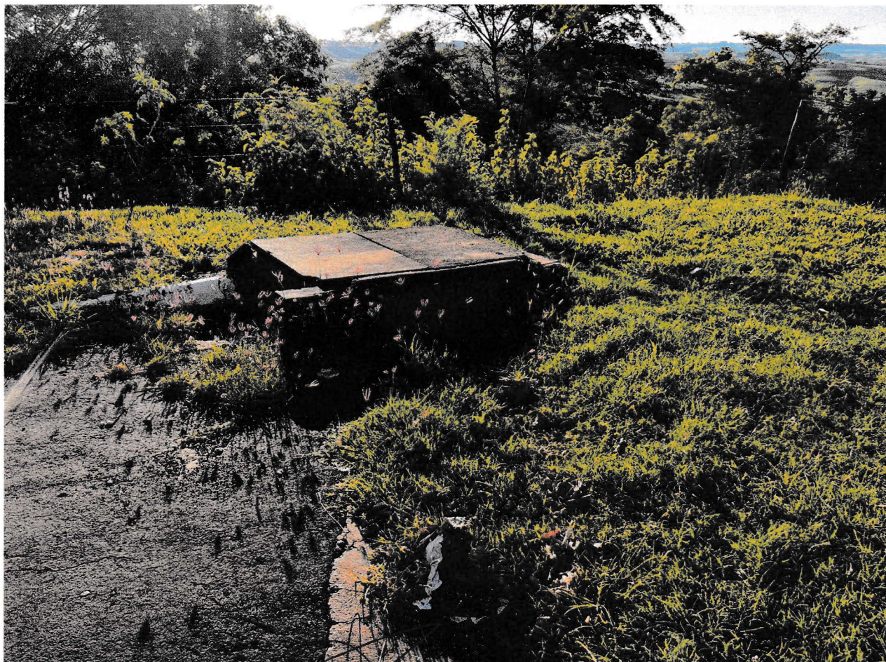
Figura 1- Bueiro citado em indicação.
