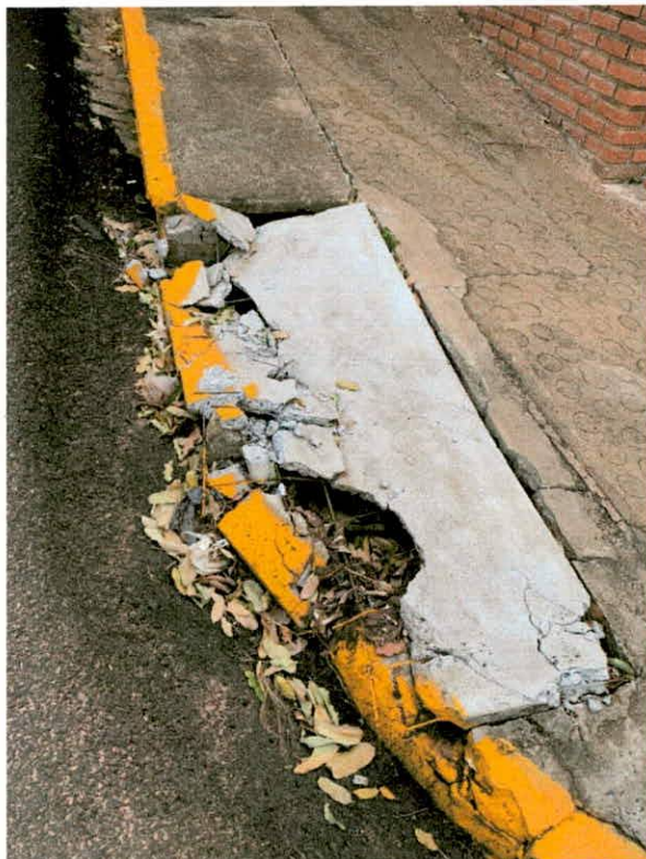
Figura 1 - Boca de lobo referida na indicação.
