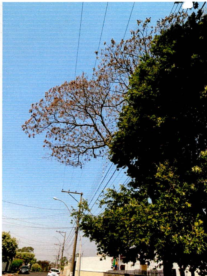
Figura 2 – Galhos da árvore em risco.
