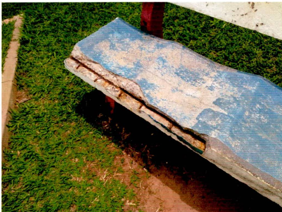
Figura 3 - Deterioração identificada em banco situado ao lado da praça.
